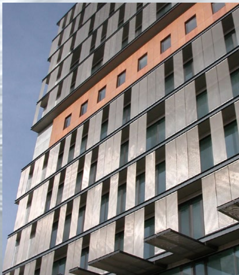
Les éléments en tissu transparent allient protection solaire efficace et remarquables possibilités d'aménagement. Façade de protection solaire EGLA-MONO 4391, Lisbonne, Portugal.
