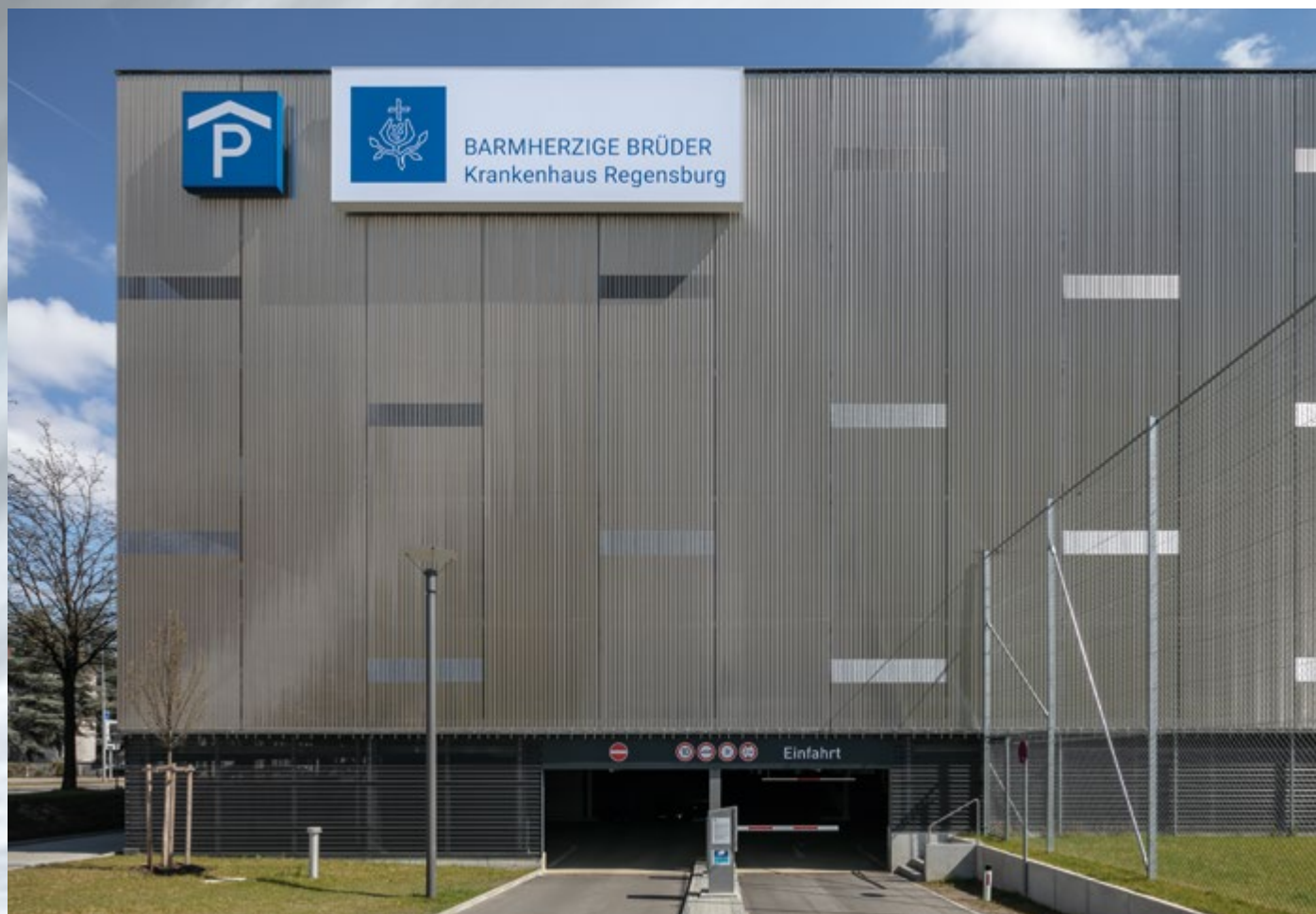
L'habillage du parking en métal tissé inoxydable LARGO-TWIST 2051 se présente fermé et pourtant transparent. Regensburg, Allemagne.
