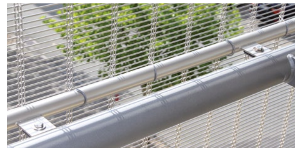
Fixation intermédiaire : profilé rond et cavalier.
