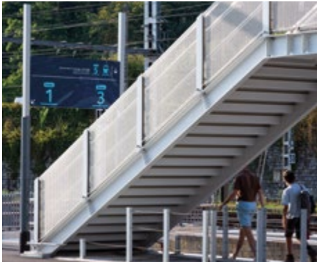
Habillage d'un pont dans une gare en tissu en acier inoxydable EGLA-DUO.
