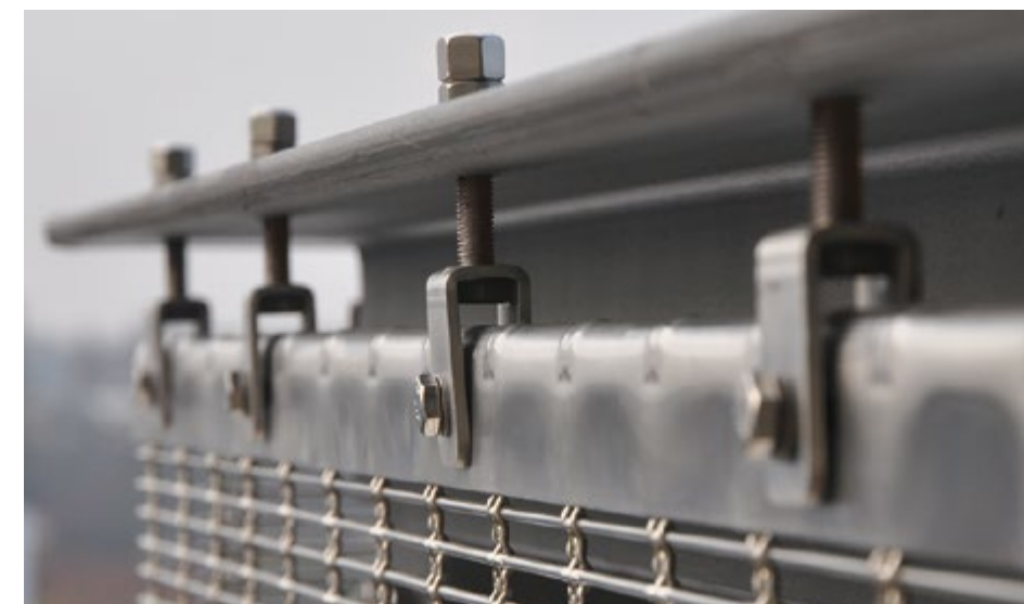
Fixation supérieure : profilé plat et chape filetée.
