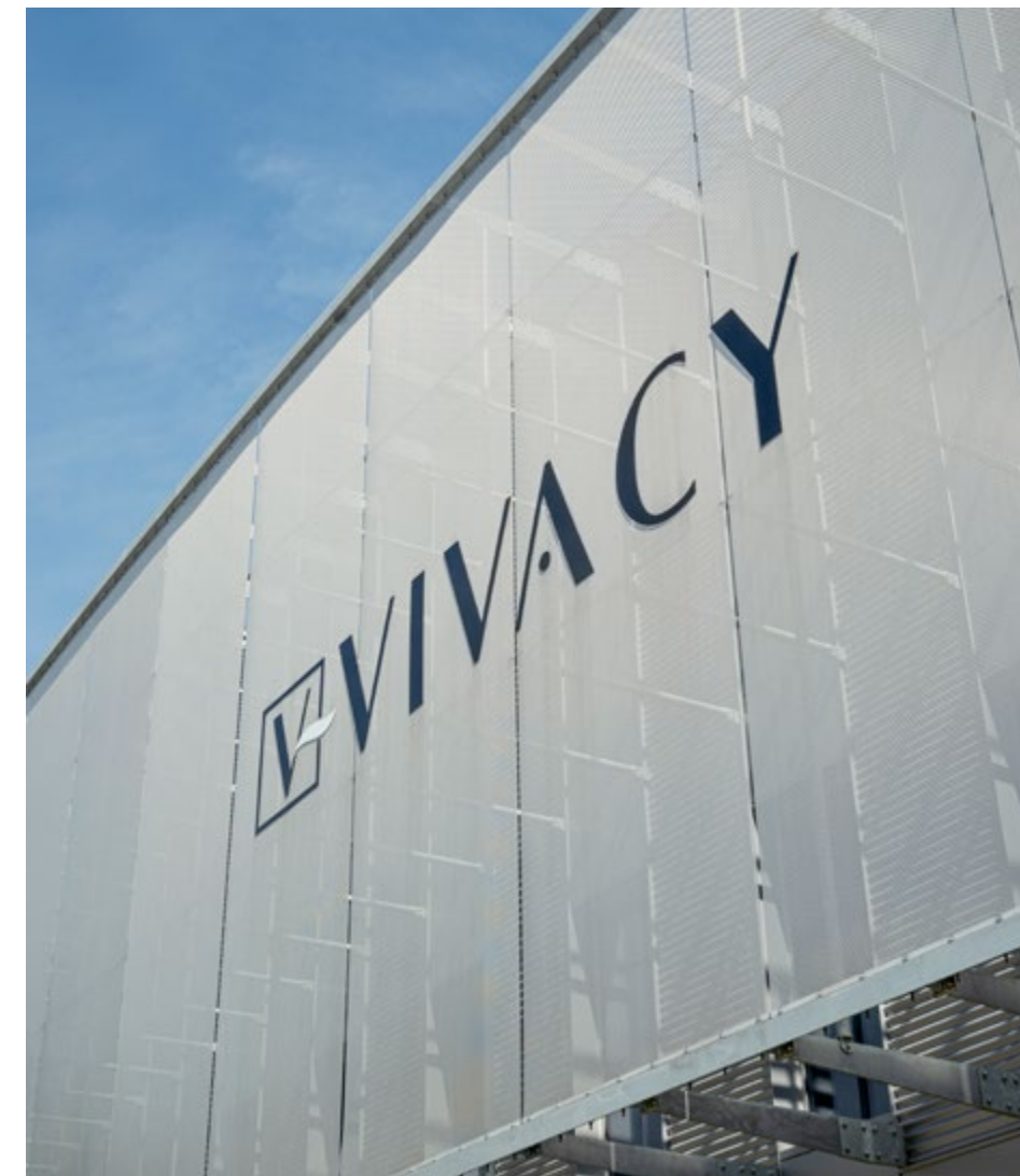
Les toiles pour l'architecture HAVER permettent d'habiller de grandes surfaces de façades tout en leur conférant un aspect visuel homogène. Revêtement de façade LARGO-PLENUS 2127, France.
