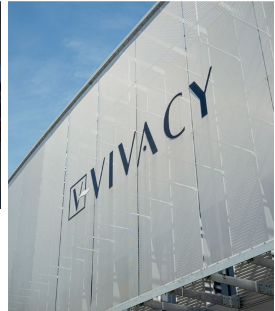
Mit HAVER Architekturgewebe lassen sich großflächige Fassaden in einem homogenen Erscheinungsbild verkleiden. Fassadenverkleidung LARGO-PLENUS 2127, Archamps, Frankreich.
