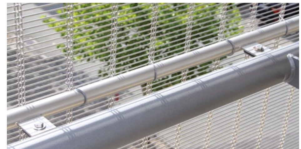
Zwischenbefestigung: Rundrohr und Drahtsicherung.
