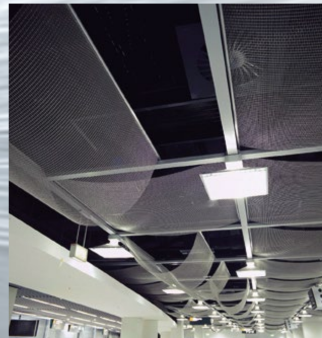
Revisionierbares Befestigungssystem für Decken mit Durchhang.
