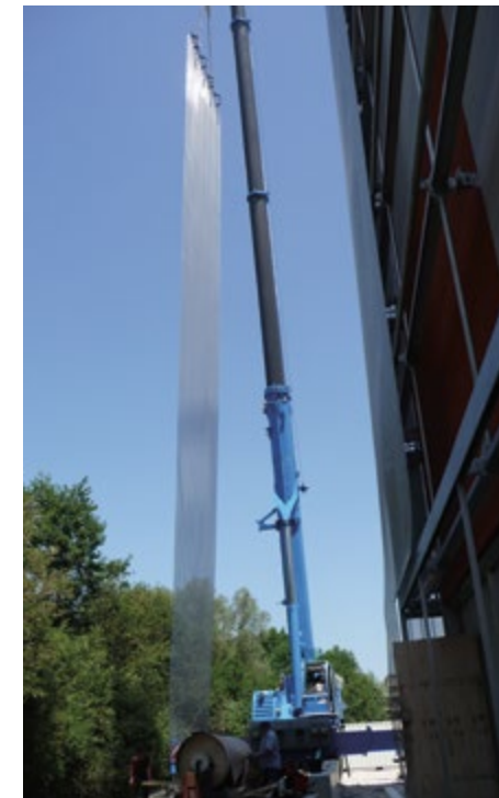
Die Montage der langen Gewebebahnen ist schnell und einfach. Einmal montiert, benötigen HAVER Architekturgewebe wenig bis keine Wartung.
