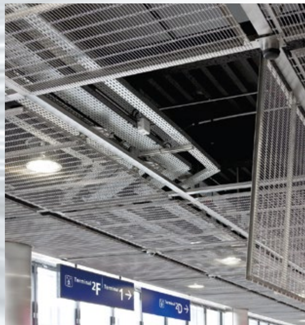
Revisionierbares Befestigungssystem für Decken ohne Durchhang mit Rahmenelementen.
