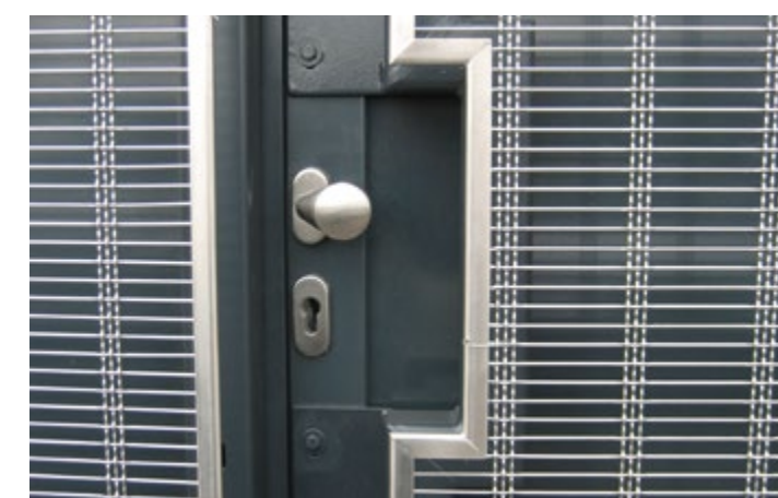
Gewebe-Einfassung mit Kantenschutzprofilen.
