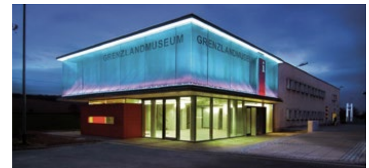
Ansicht in der Nacht mit hinterleuchtetem Drahtgewebe.
