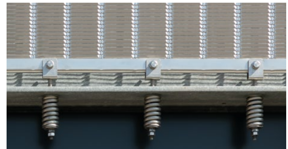
Untere Befestigung: Spannkante, Gabelschraube und Druckfeder.
