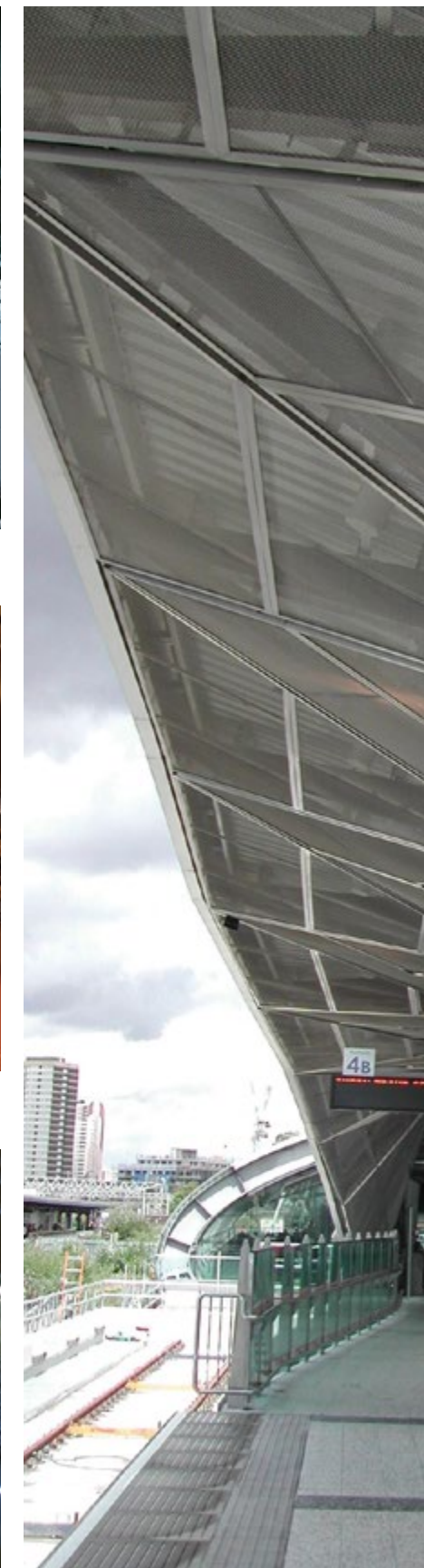
Deckenelemente, Stratford Station, London, Großbritannien, DOKAWELL-MONO 3021.
