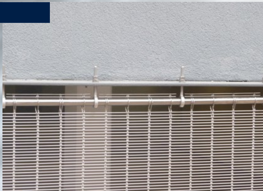
Obere Befestigung: Rundstab mit Augenschrauben.
