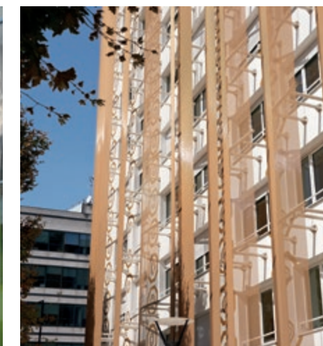
Peinture métallique. Résidence étudiante, Saint Denis, France, DOKA-MONO 1851.
