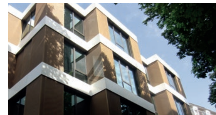
Faire du neuf avec de l'ancien. Habillage en toile pour l'architecture DOKAWELL-MONO 3601 de la façade du palais des congrès de Baden-Baden, Allemagne.
