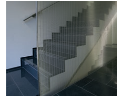
Protection contre les chutes dans la cage d'escalier avec un revêtement en MULTI-BARRETTE.
