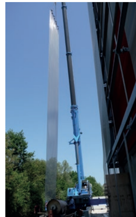
Le montage des grands lés de mailles est rapide et simple. Une fois installées, les toiles pour l'architecture HAVER ne nécessitent que peu, voire aucun entretien.
