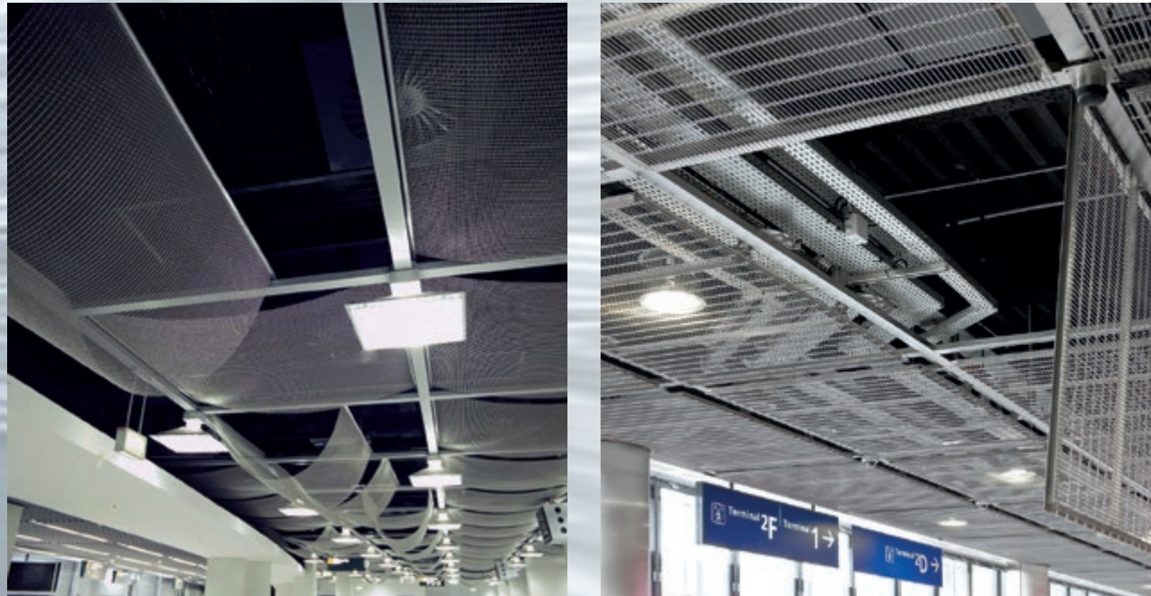
Système de fixation modulaire pour plafonds avec fléchage.
