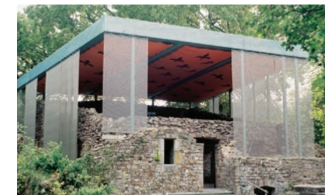
La toile semi-transparente en acier inoxydable LARGO-NOVA 2017 recouvre le bâtiment existant et confère un éclairage naturel. Eco Store C&A Eco Store, Mayence, Allemagne.
