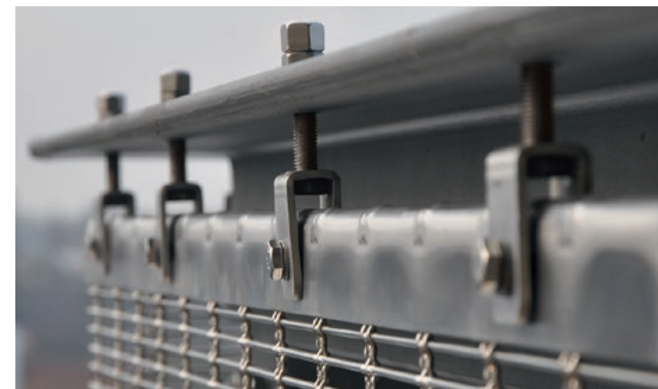
Fixation supérieure : profilé plat et chape filetée.
