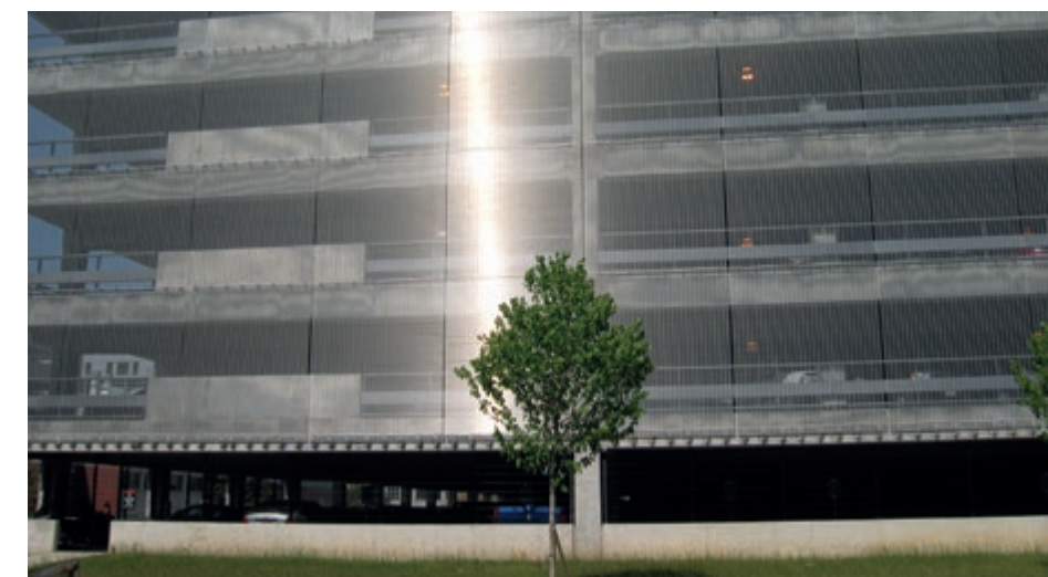
Les mailles en acier inoxydable confèrent aux façades une apparence visuelle élégante et brillante grâce aux jeux de lumière des rayons du soleil. Habillage de parking, Ohio, USA, MULTI-BARRETTE 8301.
