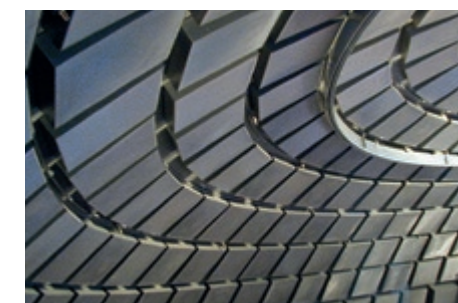
Caissons juxtaposés avec feutre acoustique. Print Media Academy, Heidelberg, Allemagne, DETENTION.
