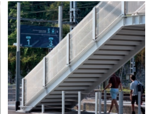
Habillage d'un pont dans une gare en tissu en acier inoxydable EGLA-DUO.
