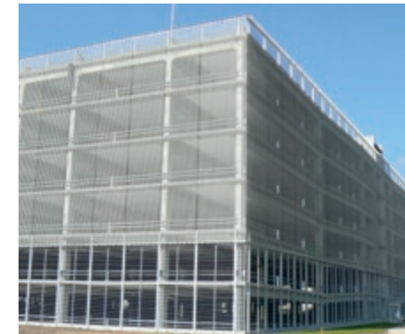
Revêtement de la façade d'un parking avec le tissu architectural HAVER DOGLA-TRIO.
