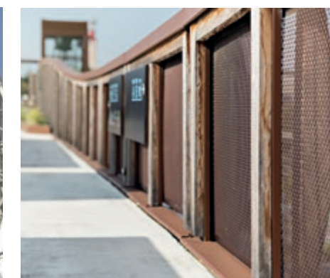
Peinture avec une peinture structurée brune. Passerelle Lisieux, France, DOKA-MONO 1421.
