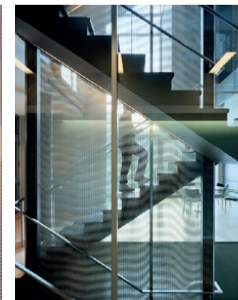
Revêtement d'une cage d'escalier avec du tissu métallique à effet moiré. Université McGill, Montréal, Canada.
