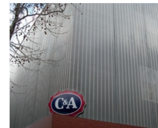
La toile semi-transparente en acier inoxydable LARGO-NOVA 2017 recouvre le bâtiment existant et confère un éclairage naturel. Eco Store C&A Eco Store, Mayence, Allemagne.
