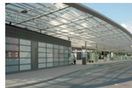
La maille métallique comme protection solaire. Gare routière de Herne, Allemagne, DOKAWELL-MONO 8967.
