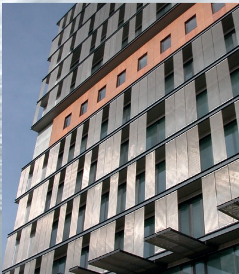
Les éléments en tissu transparent allient protection solaire efficace et remarquables possibilités d'aménagement. Façade de protection solaire ECLA-MONO 4391, Lisbonne, Portugal.
