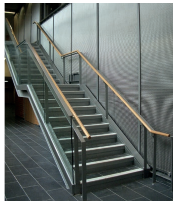
Revêtement mural et cage d'escalier. Lamton Hall, Guelph, Ontario, Canada, ECLA-TWIN 4223.
