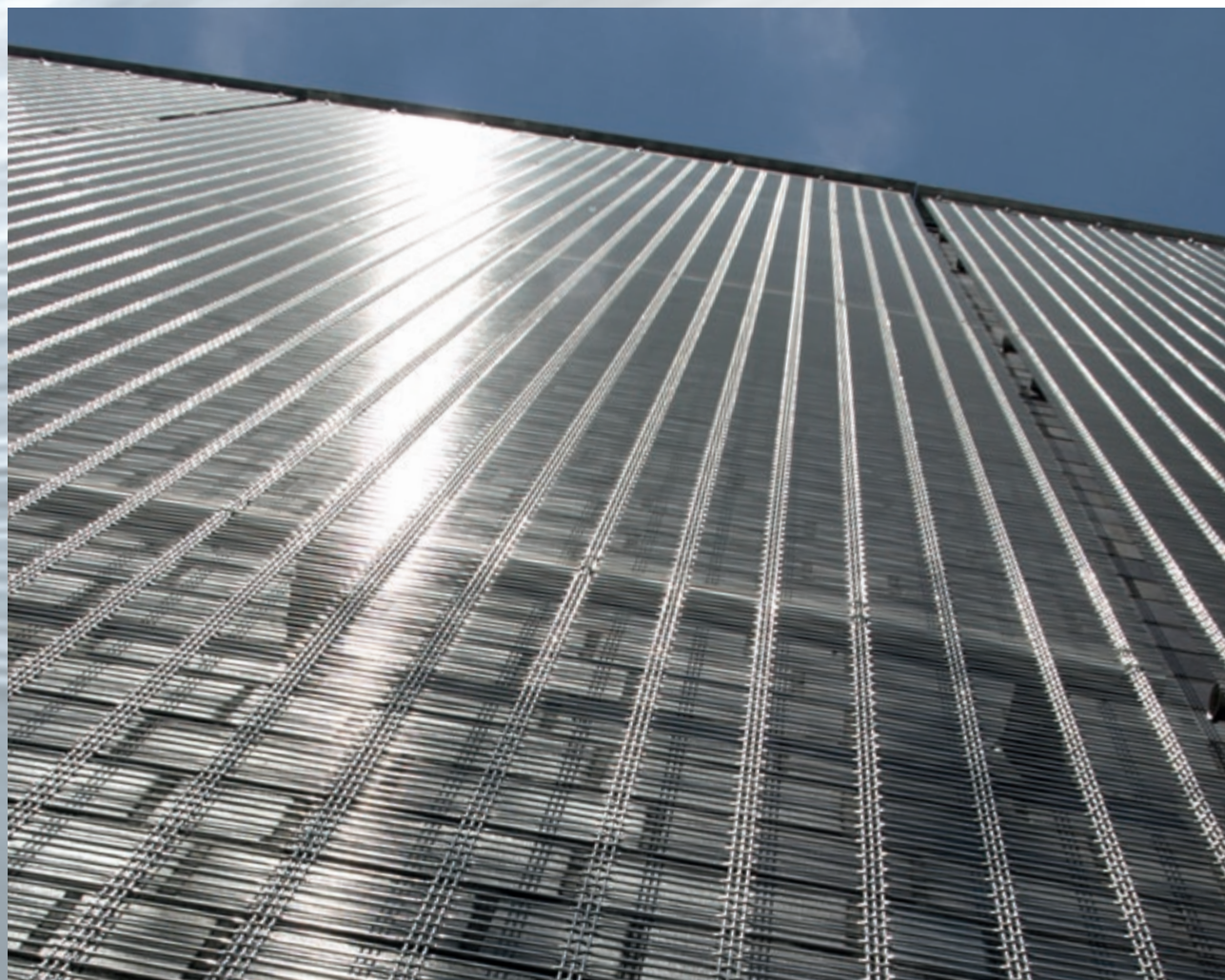
Les toiles pour l'architecture peuvent être tendues à la verticale sur plusieurs étages. Des structures porteuses sont nécessaires uniquement aux fronts supérieur et inférieur. Revêtement de façade avec DOGLA-TRIO 1032, Allemagne.
