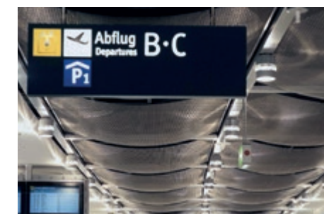
Éléments de plafond avec fléchage. Terminal B, aéroport de Düsseldorf, Allemagne, DOKAWELL-MONO 8965.
