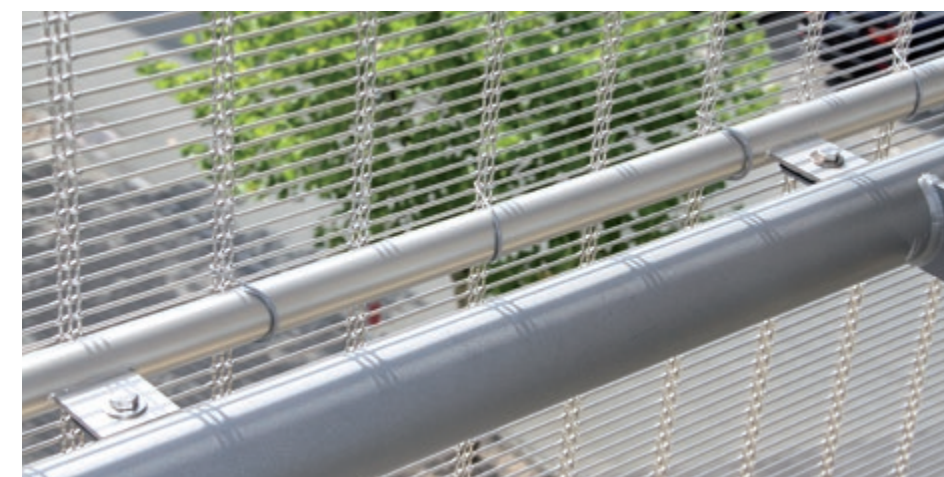
Fixation intermédiaire : profilé rond et cavalier.
