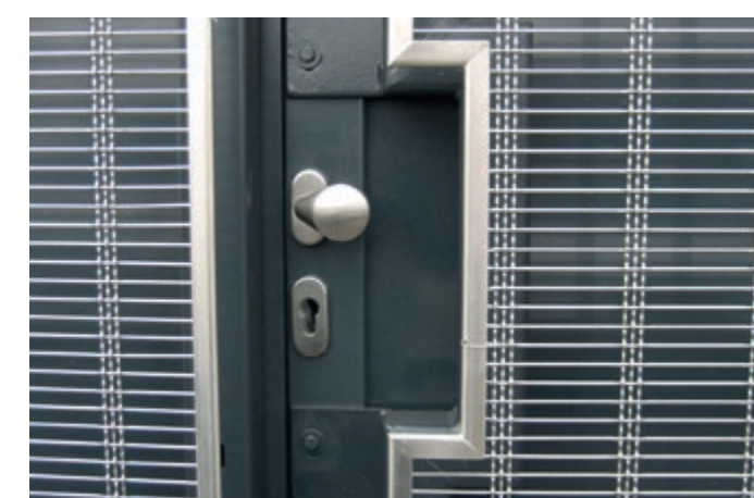
Cadre en maille avec profilés de protection d'angles.
