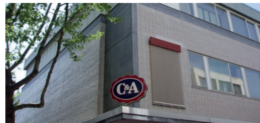
La toile semi-transparente en acier inoxydable LARGO-NOVA 2017 recouvre le bâtiment existant et confère un éclairage naturel. Eco Store C&A Eco Store, Mayence, Allemagne.
