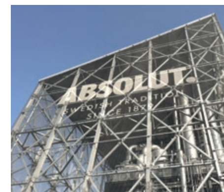
Peinture de logos. Confinement d'un bâtiment de production à Åhus, Suède. DOGLA-TRIO 1032.
