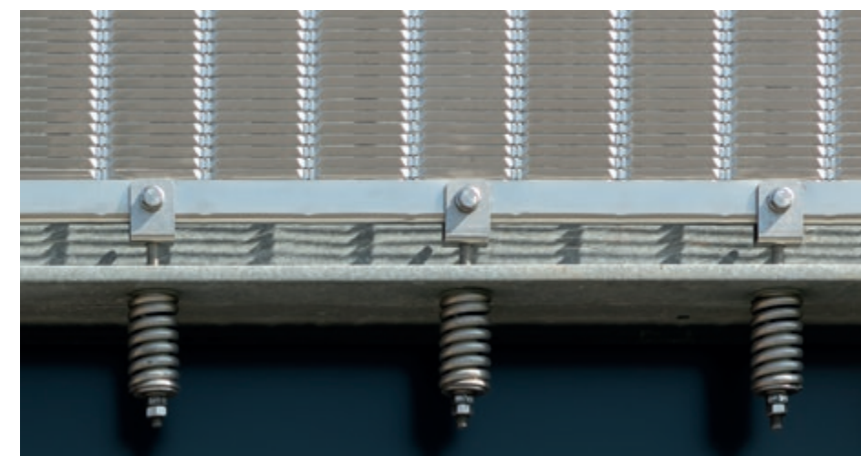
Technique de fixation pour façades en maille métallique.
