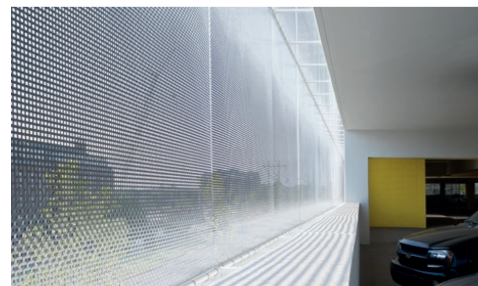
Ventilation et éclairage naturels. Parking de Chesapeake, Oklahoma, États-Unis, LARGO-PLENUS 2022.
