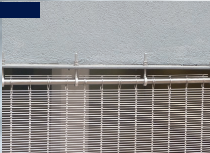
Fixation supérieure : profilé rond avec vis à œillet.
