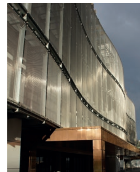
Aménagement ondulé de façade : Holland Park School, Londres, Grande-Bretagne, EGLA-MONO.
